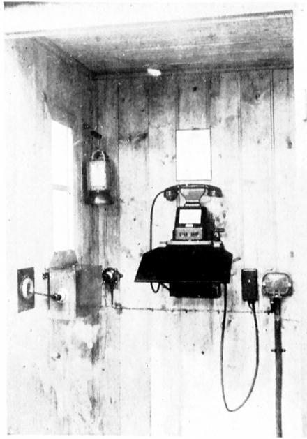
Bild 24. Fernsprechbude an gekabelten Strecken.
