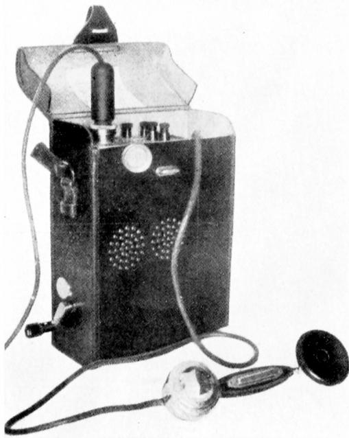
Bild 30. Fernsprecher geöffnet, betriebsfertig (Anschluß an tragbares Kabel).
